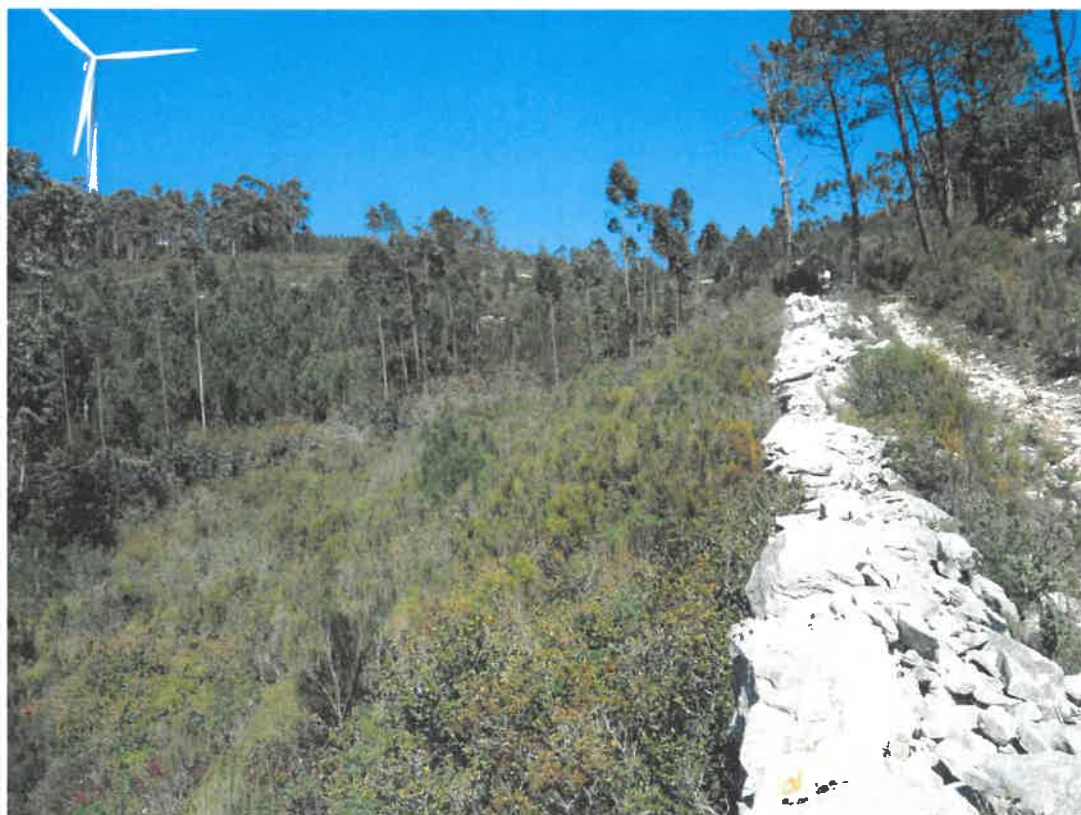
Fot.10 – Caminho sustentado por espesso muro em pedra seca.
