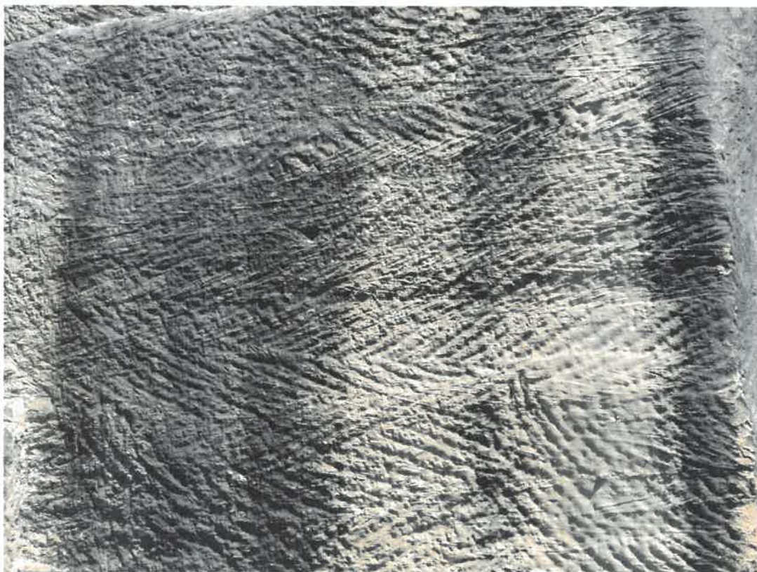
Fot.18– Explorações da Barrosinha (n.º4) : pormenor das marcas deixadas aquando do desbaste, com martelos denteados ou gradins.
