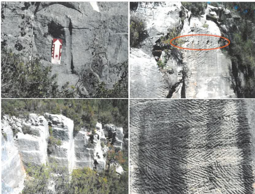
Fotografia 15, 16, 17, 18 – Vestígios de exploração de pedra – “Explorações da Barrosinha” (n.º 4): sulcos provenientes das cunhas; orifícios deixados pelo escopro; vista de uma frente de exploração; pormenor das marcas deixadas aquando do desbaste, com os martelos denteados ou gradins.
